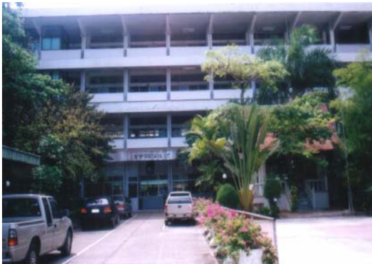
อาคาร 3 คณะพื้นฐาน
