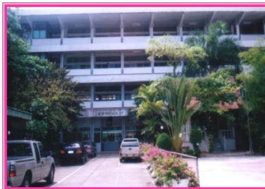
อาคาร 3 คณะวิชาพื้นฐาน
