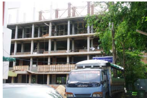
อาคาร 2 (5 ชั้นกำลังก่อสร้าง)
